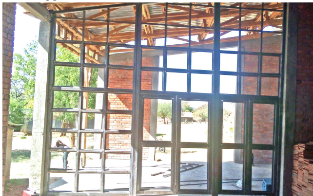
Zwischenstand der Baumaßnahmen
